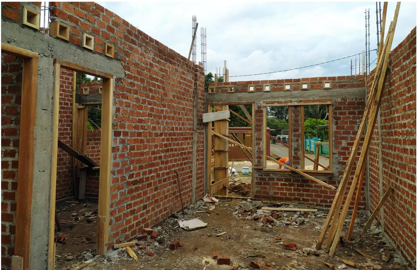
**Gambar 3.** Gambar Perkuatan dinding diatas kusen Pintu jendela menggunakan Metode beton Latei
