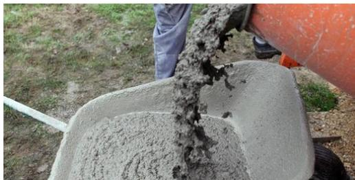
Gambar.5 Photo Beton sebagai bahan dasar pembuatan balok latei
