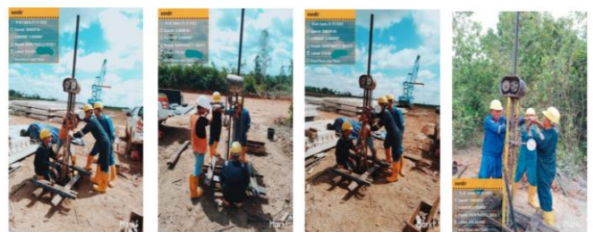
Gambar 5. Lokasi STA 83+503 – 83+975 sedang dilakukan Soil Investigasi (Sondir)
