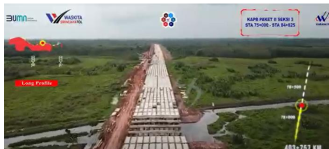
Gambar 4. Pekerjaan PileSlab dilokasi Proyek Kayuagung Palembang Betung Paket II seksi 3.
