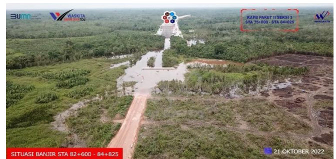
Gambar 1. Pada STA. 83+503-83+975 ruas Jalan Tol Ruas Kayu Agung-Palembang Betung Tahap II seksi 3.
