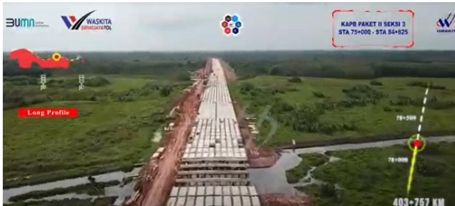
Gambar 2. Pekerjaan PileSlab dilokasi Proyek Kayuagung Palembang Betung Paket II seksi 3.
