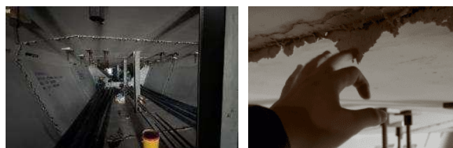
Gambar 18. Sisa epoxy yang meluap dan mengeras setelah joint segmen box girder
