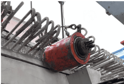
Gambar 4. Penggunaan internal prestress
