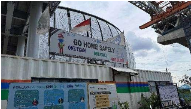
Gambar 19. Rambu-rambu K3 yang terpasang di lokasi proyek
