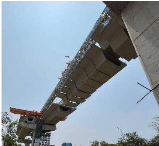
Gambar 7. Metode erection box girder dengan span-by-span
