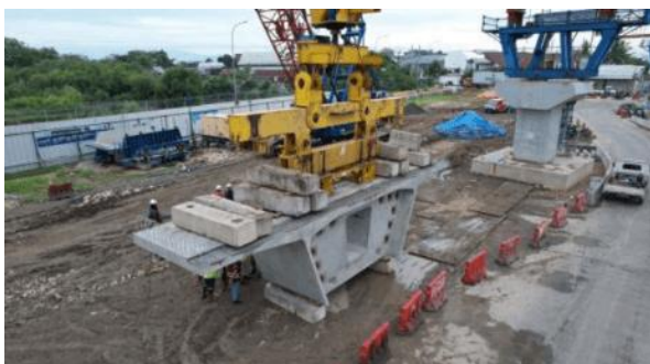
Gambar 13. Uji beban pada launching gantry
