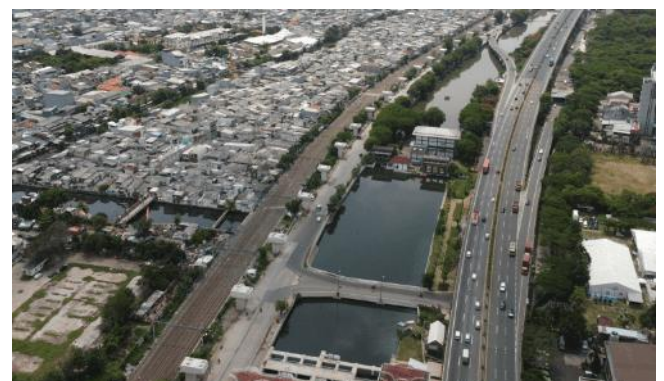
Gambar 11. Proses konstruksi double box girder
