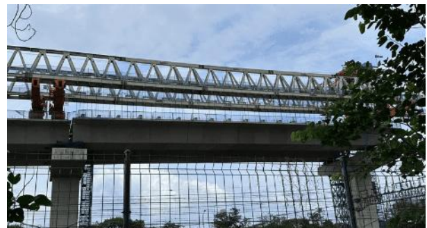
Gambar 6. Penggunaan box girder dengan constant depth menggunakan full span launching gantry
