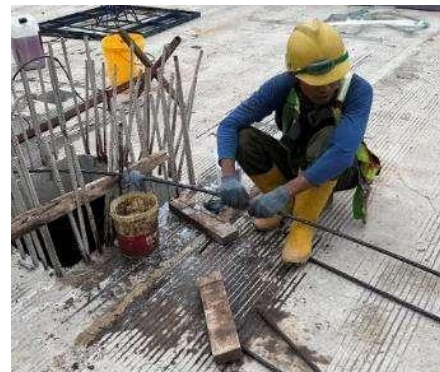
Gambar 14. Pelapisan cairan anti karat pada strand
