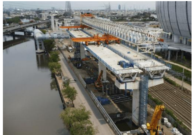
Gambar 10. Proses konstruksi double box girder
