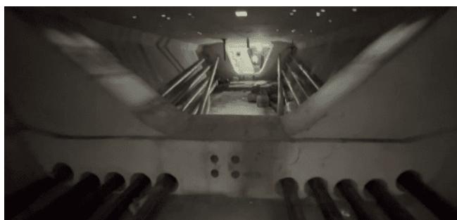
Gambar 16. Tendon di dalam pipa HDPE yang telah digruting
