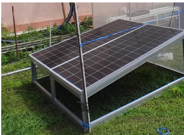
Gambar 1. Panel Surya dan strukturudukan nya
