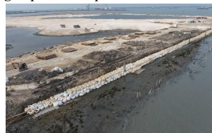
Gambar 11. Pemasangan sandbag
