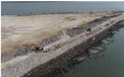
Gambar 13. Pemasangan Batu Primary
