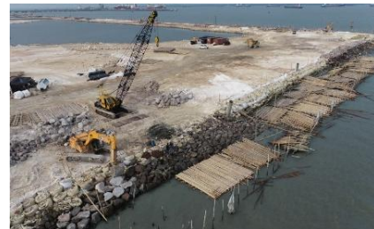
Gambar 10. Pemasangan Matras Bambu
