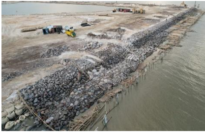
Gambar 12. Pemasangan Batu Secondary
