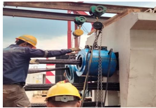
Pemasangan Hydraulic Jack
