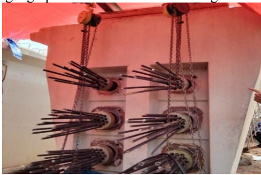
Pemasangan Anchor Block dan Wedges
