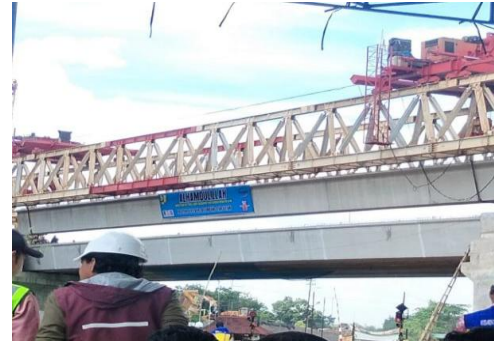
Pekerjaan Erection Girder
