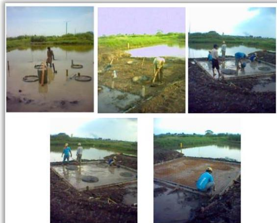
**Gambar 14.** Pembuatan prototipe slab perkerasan Cakar Ayam Modifikasi dengan 4 pipa cakar ayam pada tanah lunak.
